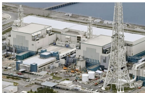
新潟県の東京電力柏崎刈羽原発の6号機と7号機=共同
