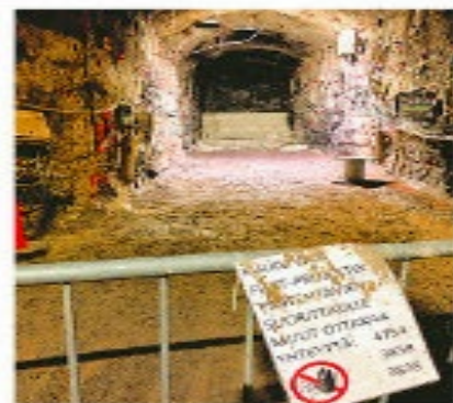
地下420mにある使用済み 核燃料の埋め立て場所
