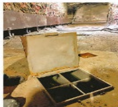
使用済み核燃料を埋設する 深さ7mの縦穴
